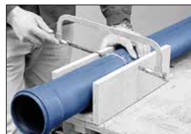
Længdetilskæring ved hjælp af en fintandede sav (FIGUR 17)
