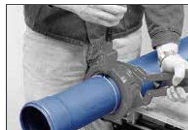
Længdetilskæring ved hjælp af skære- og affasningsværktøj (FIGUR 16)
